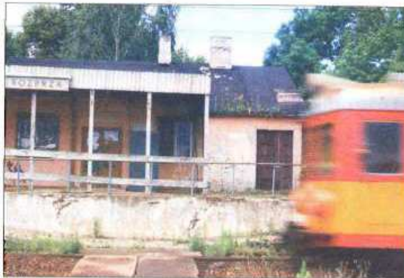
Budynek stacji PKP w Rozprzy dziś zostanie zburzony
