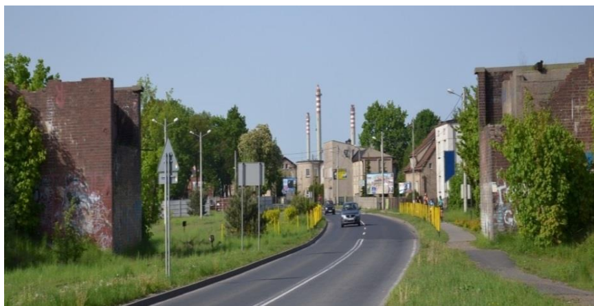
Podpory kolejowego mostu nad szosą Miasteczko Śl. – Tarn-Góry. Wł. fot. Grzegorz Marszałek.
